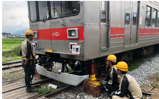
脱線復旧訓練
